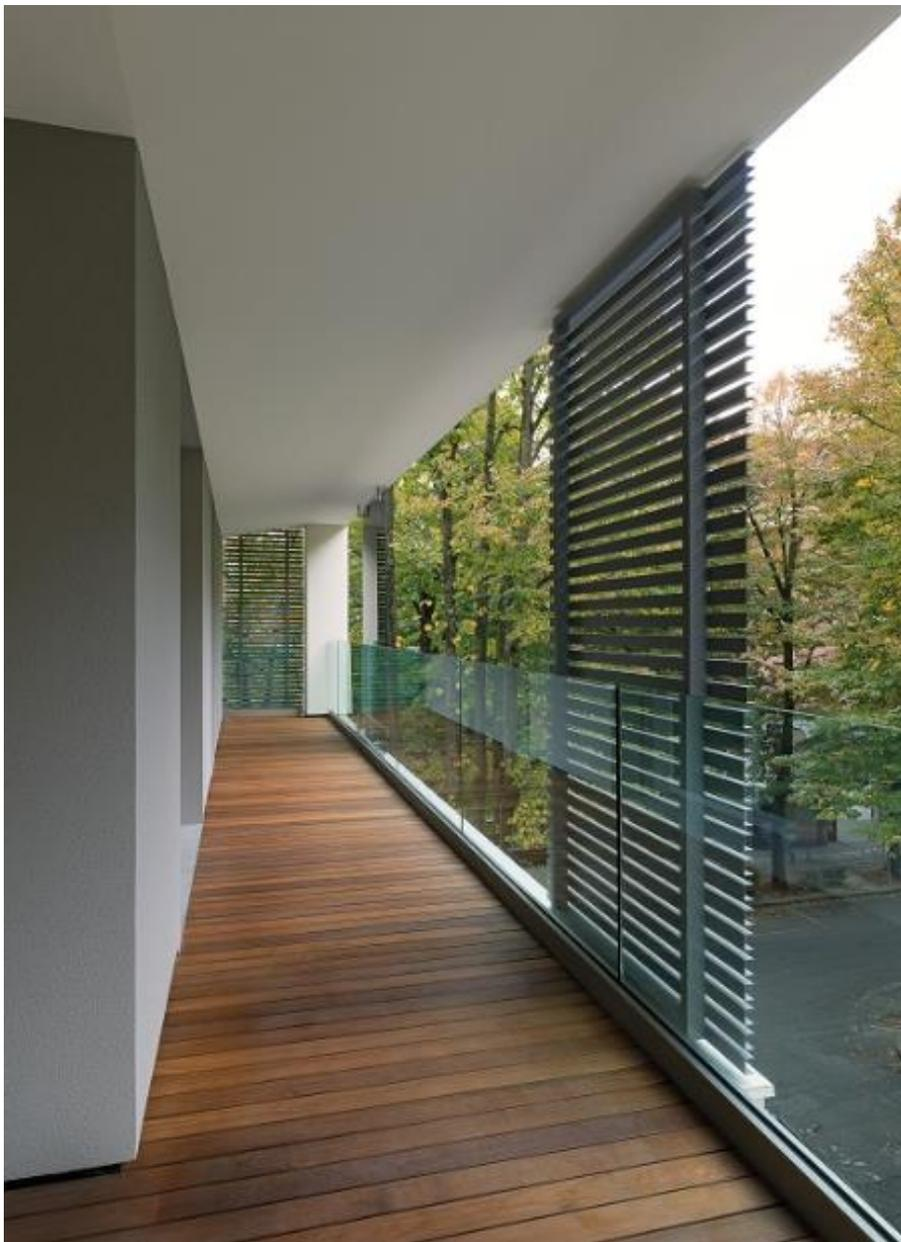
Tutti i balconi e le logge hanno una pavimentazione in doghe di legno e sono attrezzati con una serie di frangisole in alluminio verniciato
