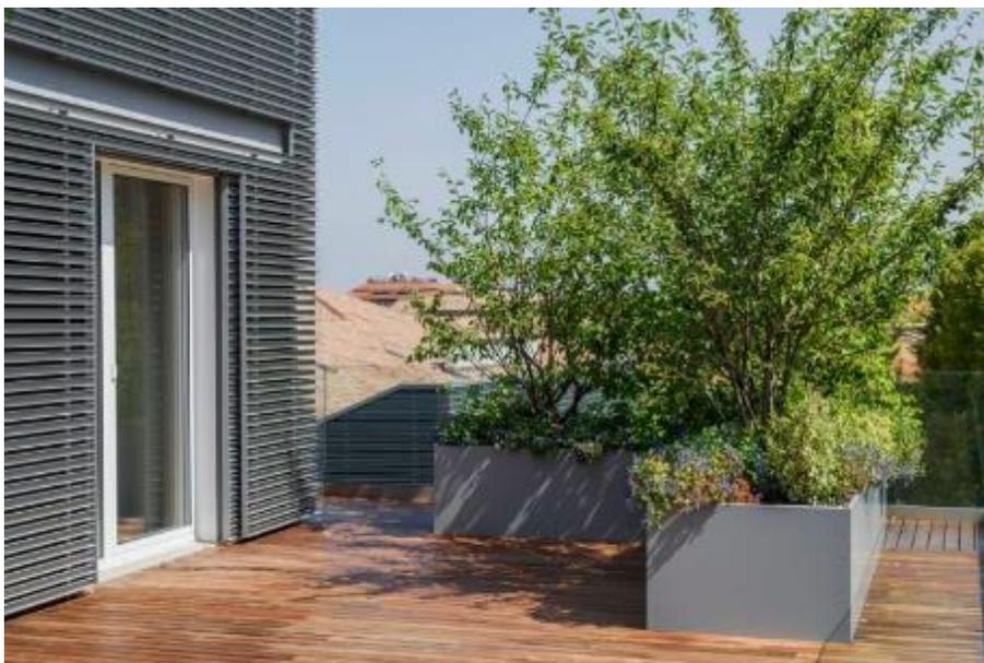
I volumi in copertura sono rivestiti in esterno con listellature in alluminio con pavimentazione in listoni di legno per le terrazze
