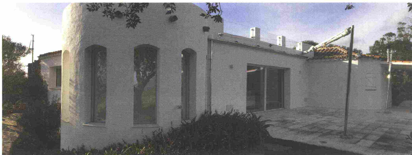
Località Murta Maria (Olbia), Villa Ortensie, ristrutturazione. Serramenti in alluminio minimal Metra
